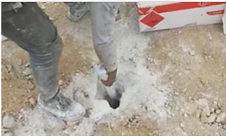
Figura 4. 2-Risconº2-Carregamento dos furos
